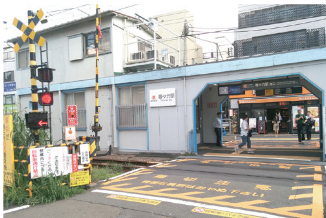
構内踏切のあるローカルな雰囲気「等々力」駅
