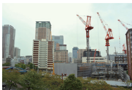
高層マンション建設が進む再開発工事地域
