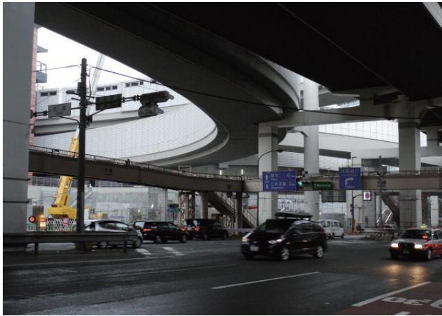
建設中の「首都高速・大橋ジャンクション」
